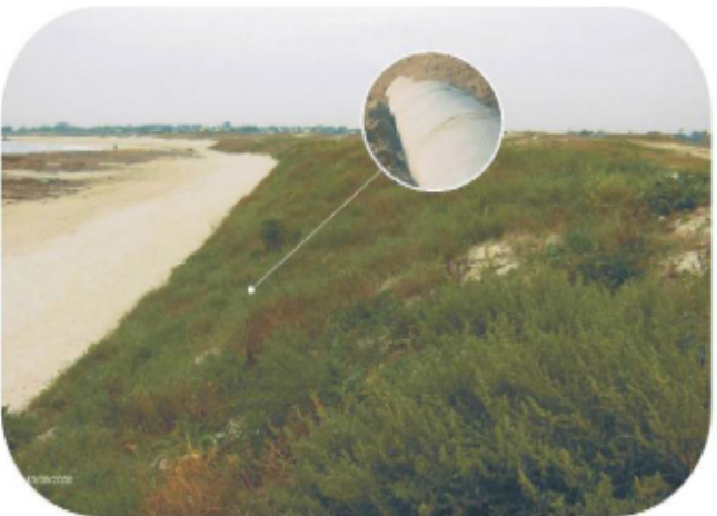
Linha de duna da praia Le Guilvinec 2005 Duna após o termino da obra
